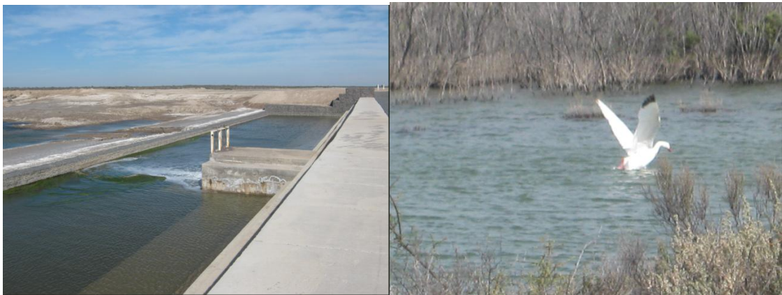
Figura 5.7 y 5.8 Azud N° 1. Las fotos de arriba y éstas, tomada en 2014, en el azud N° 1
